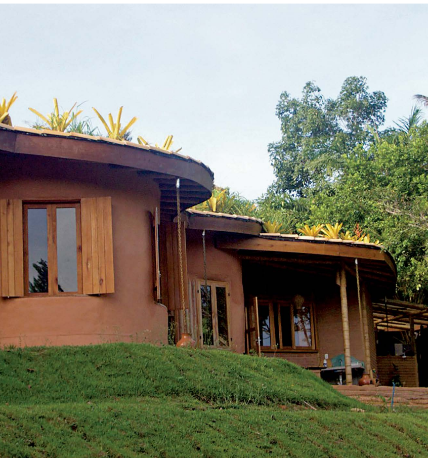
Cercada pela Mata Atlântica, a Escola Comunitária Maramar tem estrutura erguida com ecotijolos, feitos de terra comprimida retirada de terraplenagem e moldada pelos pais dos alunos. Destaque para o sistema de ventilação permanente, telhado verde nas áreas comuns e agrofloresta pedagógica.
